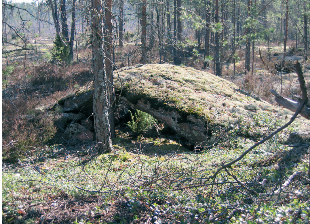
Kuva 1. Siltakivi Virolahden Sydänkylässä. Sillan pituus on 4 m, leveys 1,5 m ja paksuus 30–40 cm. Sen laki nousee 70 cm ympäristöstään. Puolimetrisen kataja sinnittelee sillan alla vuonna 2006. Kuva: S. Kielosto.
