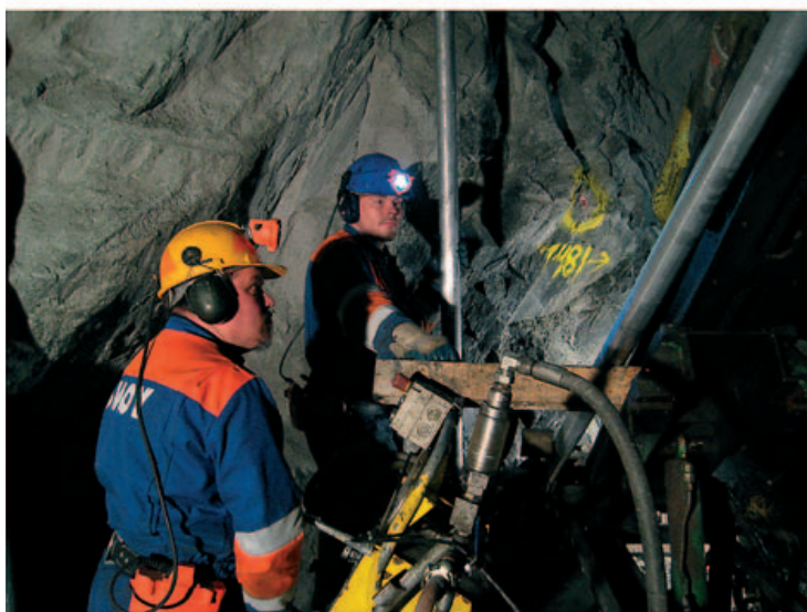
Timanttikairausta Pampalon vinotunnelissa
