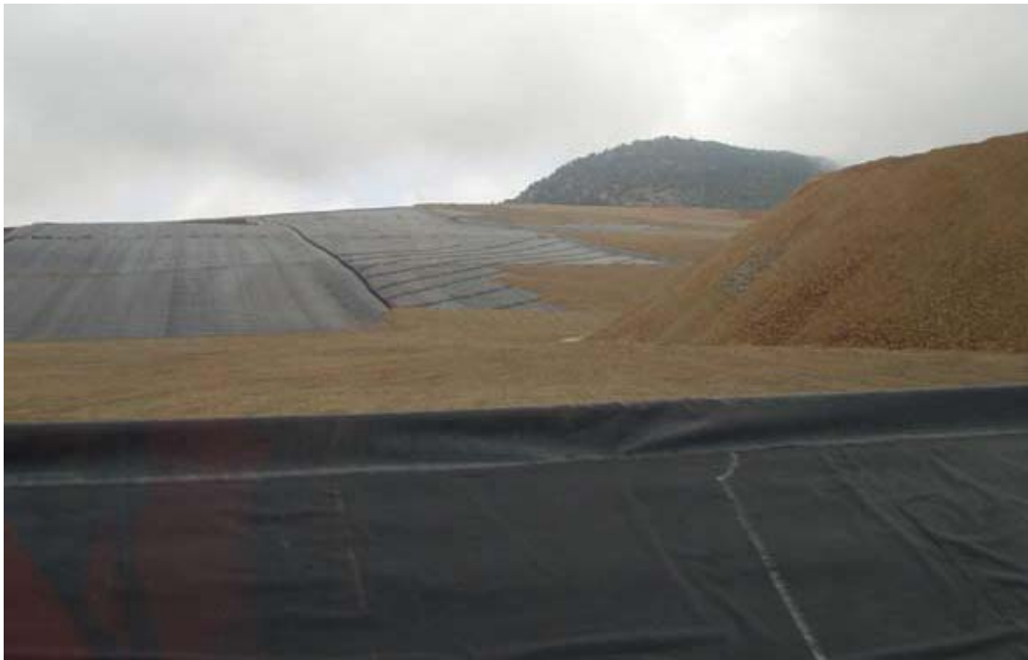
Kuva 2. Kışladağin syanidiliuotuskasan rakennetta: alinna sorakerros, sen päällä savikerros ja päällimmäisenä muovipeite, joka on hitsattu reunoistaan vedenpitäväksi ja varustettu syanidiliuotuksen keräysviemäreillä ja putkistolla. Kuva: Kari Kojonen.
