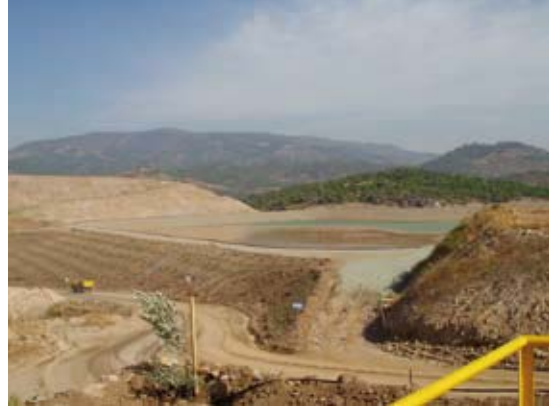
Kuva 6. Ovacikin kaivoksen jäteallas, josta vesi pumpataan takaisin rikastusprosessiin. Kuva: Kari Kojonen. Figure 6. Tailings pond of the Ovacik cyanide leaching process. The water is pumped back in to process. Photo by the author.
