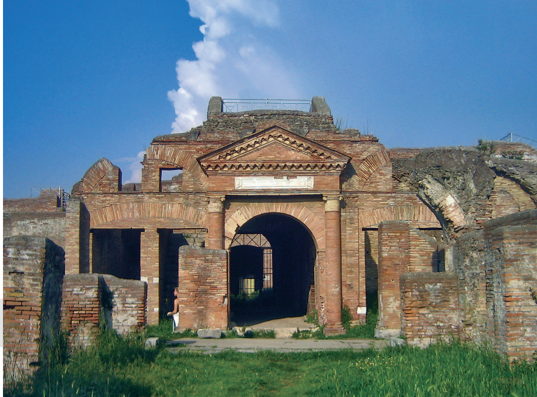
Kuva 1. Ostia, Rooman satamakaupunki, on tunnettu tiiliarkkitehtuuristaan. Kuvassa Epagathianan ja Epaphroditianan viljavarasto (ajoitus n. 140–150 jKr.). Kuva: J. Ikäheimo.
