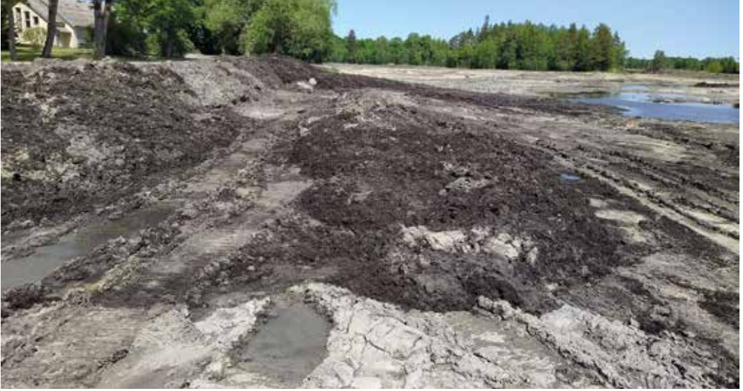
Kuva 1. Kuivumaan kasattua sedimenttiä tilapäisesti tyhjennetyn järven pohjalla. Kuva Kernusta, Virossa. Kuva: Arto Itkonen.
