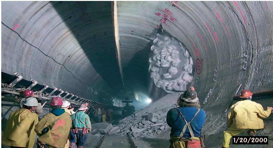
Kuva 1. Täysprofiilikone Robbins TMB (Tunnel Boring Machine) jyrsimässä tunnelia Chicagossa USA:ssa siluuri-kautiseen kovaan dolomiittikalkkikiveen (Lach et al. 2000).
