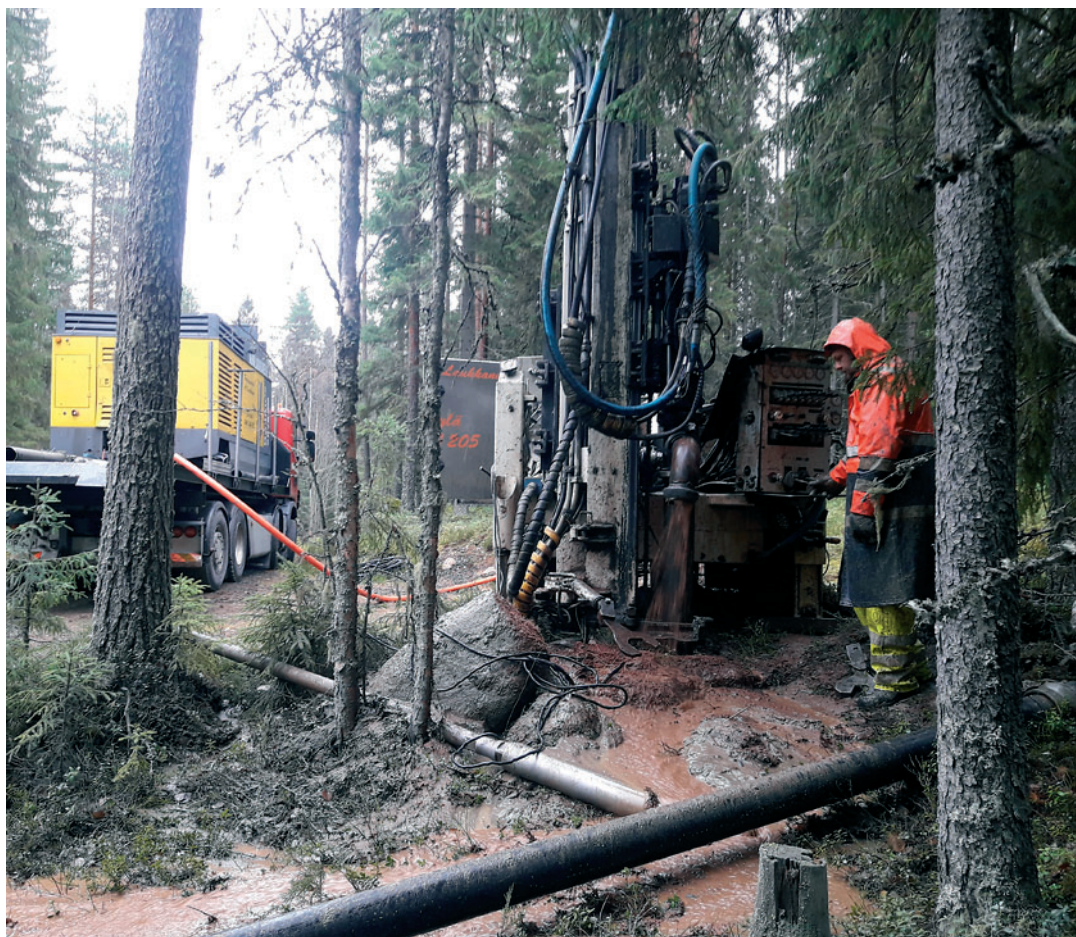
Kuva 4. Kaivon DW1 poraus käynnissä Petäjäveden Syrjäharjulla 24.10.2019. Kuva: Ossi Alho
