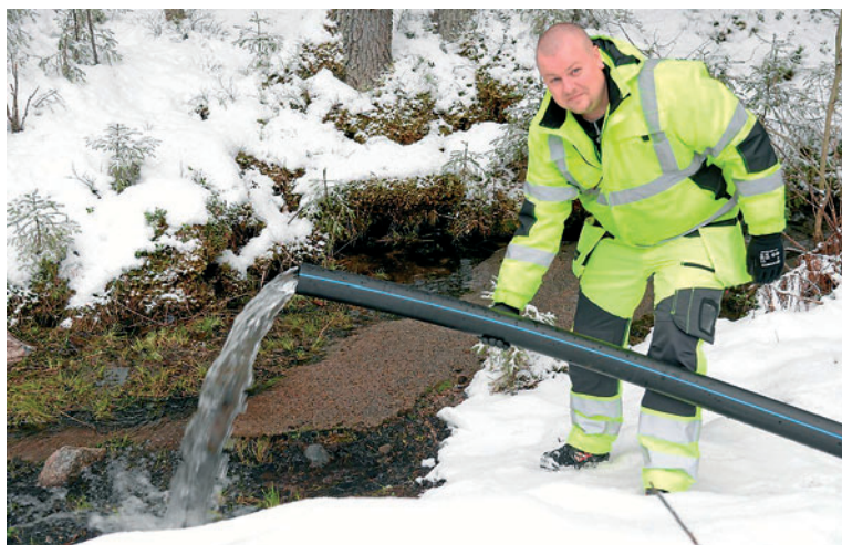
Kuva 8. Syrjäharjun porakaivon DW2 lappopumppaus käynnissä 6.3.2020. Pohjavettä purkautuu PE90-putken päästä lähdekaivon laskuojaan 600 \text{ m}^3/\text{vrk} . Putkea pitelee vesilaitoksen hoitaja Mikko Lämpsä. Kuva: Pertti Perämäki Sanomalehti Keski-Suomalainen 7.3.2020
