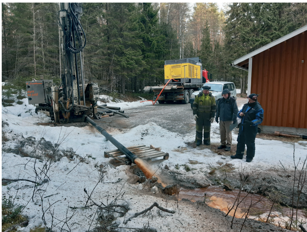
Kuva 5. Syrjäharjun kaivon DW2 poraus käynnissä vedenottamon tontilla 23.1.2020. Poraussyvyys 19 m mp:sta, vedentulo noin 700 m 3 /vrk. Kuva: Ossi Alho
