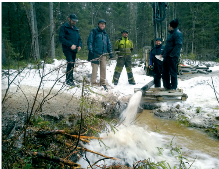
Kuva 6. Syrjäharjun porakaivon DW2 huuhtelupumppaus menossa 23.1.2020. Porareian loppusyvyys 31 m, vedentulo 1 560 m 3 /vrk. Kuva: Ossi Alho
