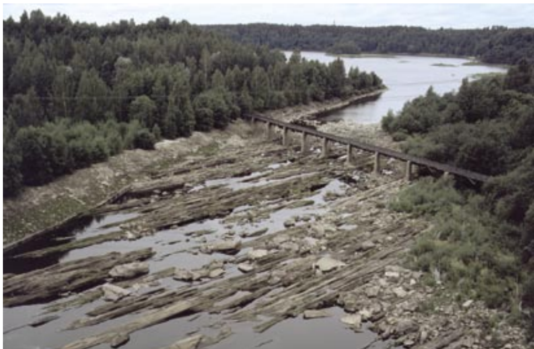
Kuva 11.4. Harjavallan voimalaitoksen purkauskanavan jotunihiekkakivipaljastuma Lammaistenkoskella. Hiekkakivikerrokset ovat kallistuneet voimakkaasti lounaaseen (takavasemmalle). Kuva Pekka Pihlaja.
